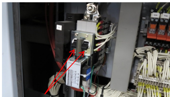
Zapnutý odpojovač, páky dole
